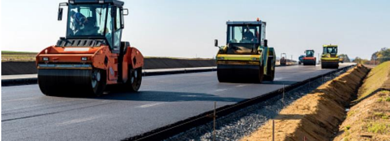
Figure 2. Pavage de route à l'aide d'asphalte caoutchouté. Photo : Liberty Tire Recycling
